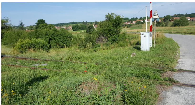
Slika 3.6. Željeznička pruga Križevci-Kloštar Podravski na lokaciji u Sirovoj Kataleni
